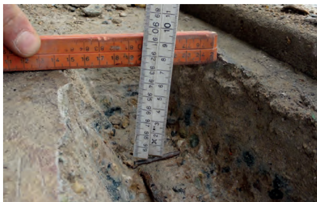
Figuur 3-3 Verificatie wapening vanaf bovenzijde galerijvloer.
