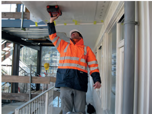
Figuur 3-2 Radarmeting aan onderzijde galerijvloer.
